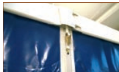
Tensionamento dei teli dei tetto
