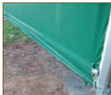
Tensionamento inferiore teli laterali
